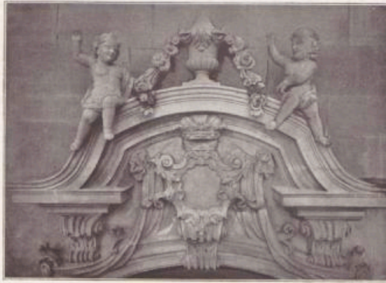
Von der Fassade der Würzburger Residenz.
