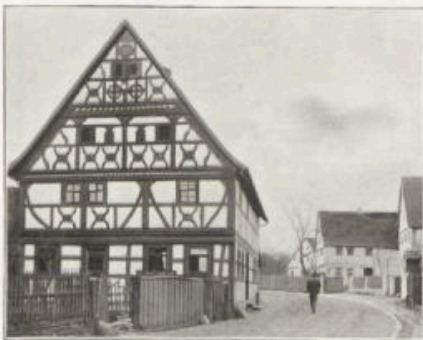
Haus in Unterweißenbrunn.
